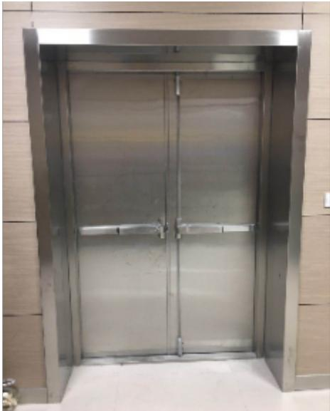
轩源门框：标准对轩源门框背火表面比较高温升的要求由180℃提高至360℃，标准降低，但轩源门框的隔热性问题也不容易忽视。轩源门框背火面热量主要来源于两个方面：轩源门框材料本身对热量的传导和轩源门缝处热量的传导。解决方法：①减少轩源门框材料本身的热量传导。木质轩源防火门选择热传导率较低或耐火性能好的木材，也可以在门框表面粘贴防火板。钢质轩源防火门可以门框中间用防火板、隔热材料或开槽的方式设置热量断桥。②减少缝隙处热量传导。可以增大搭接量，多设置密封条或设置多道密封条。镇江机房隔音防火门报价轩源牌子的甲级防火门怎么样？
